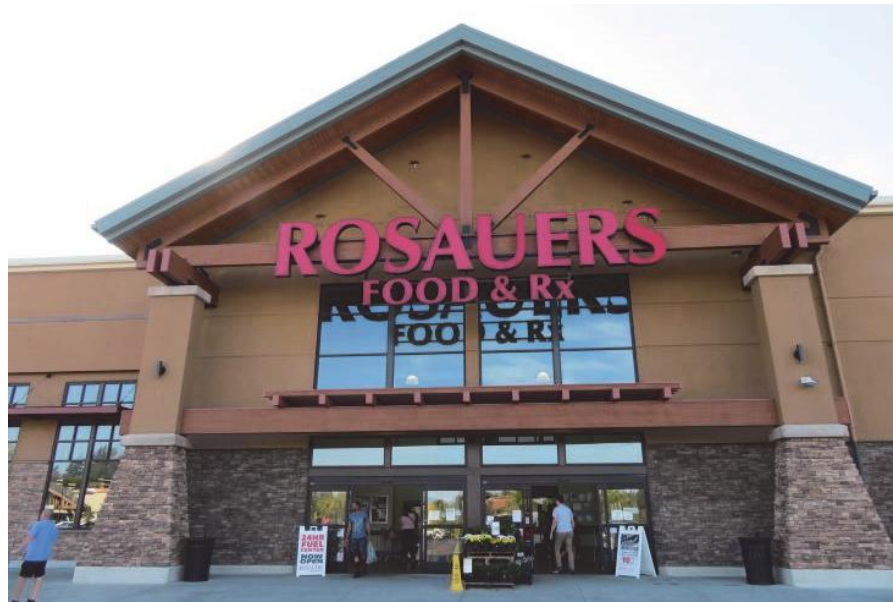
ROSAUERS 店舗外観（駐車場は広い）
