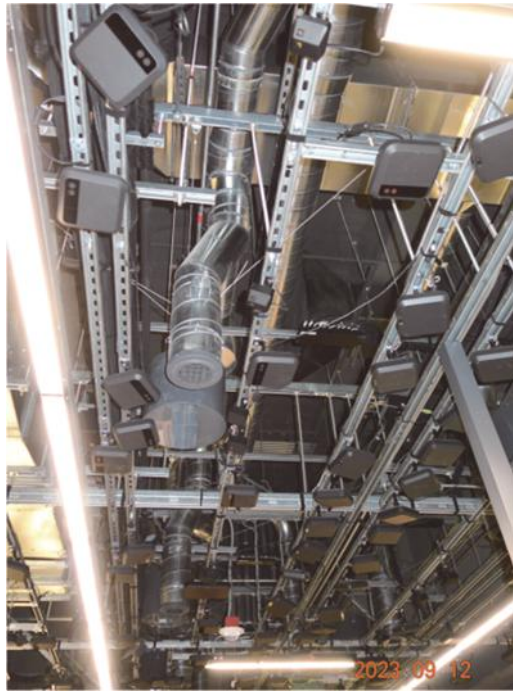
天井に設置されたカメラ、センサー、 マイク類
