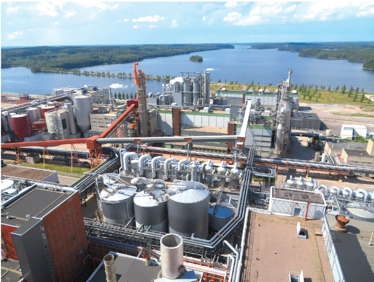
回収ボイラ上からの工場写真
